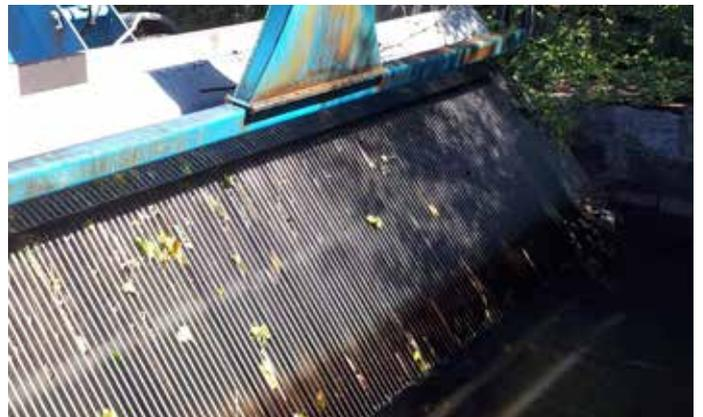
Le dégrilleur de la centrale hydroélectrique.
